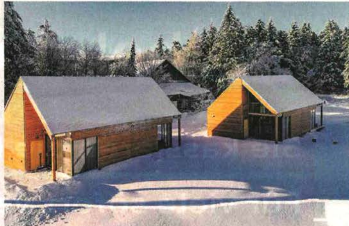
Die nunmehr fertiggestellten „Sternenparkhäuser“ im vergangenen Januar. Foto: Feriendorf Wasserkuppe/Archiv
