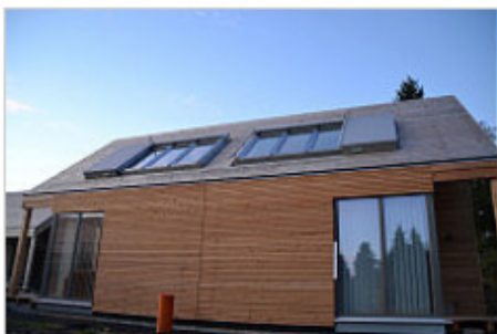
Die beiden großen Dachfenster
